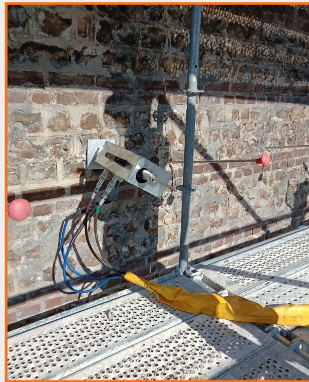
Réalisation de l'injection de résine
