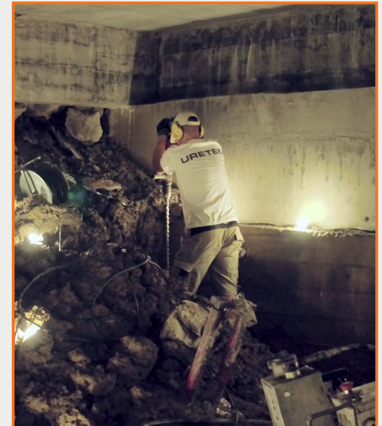
Percements réalisés depuis les vides sanitaires
