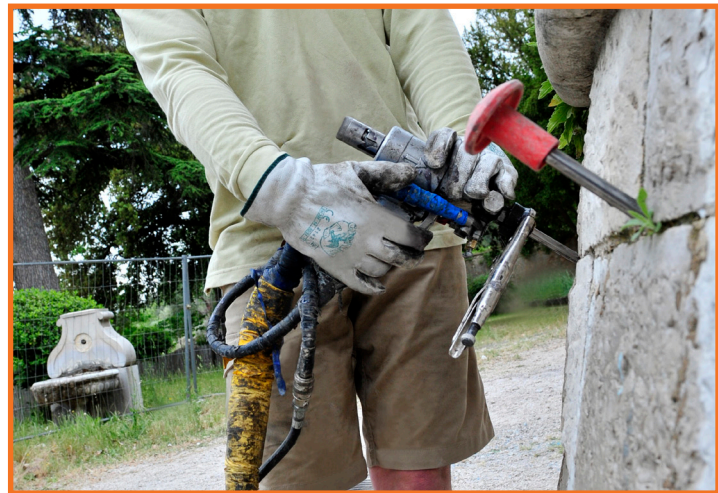
Injection de la résine IDRO CP 200 Premium
