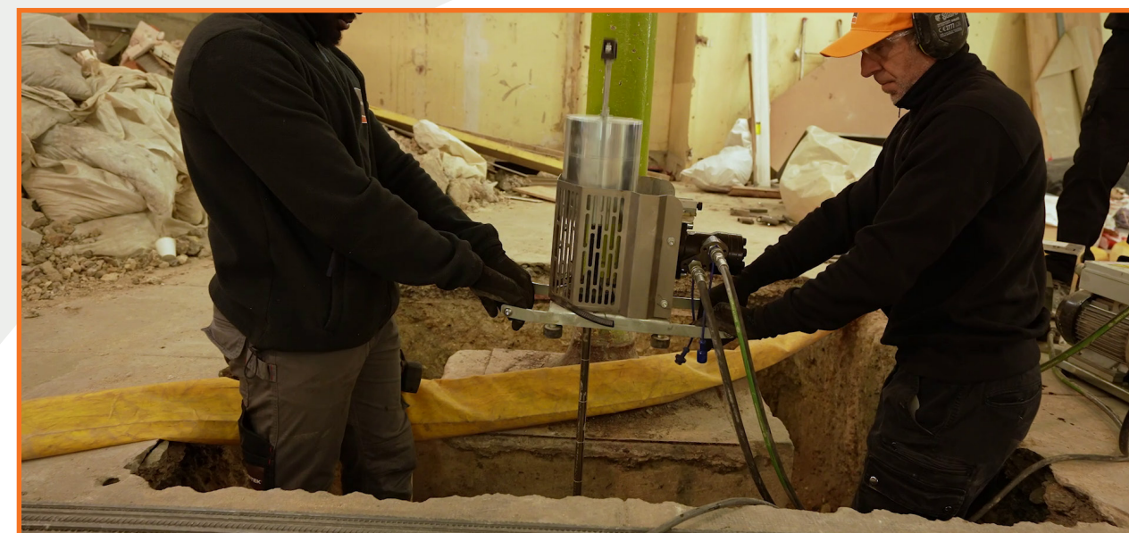
Réalisation d'un test pénétrométrique comparatif
