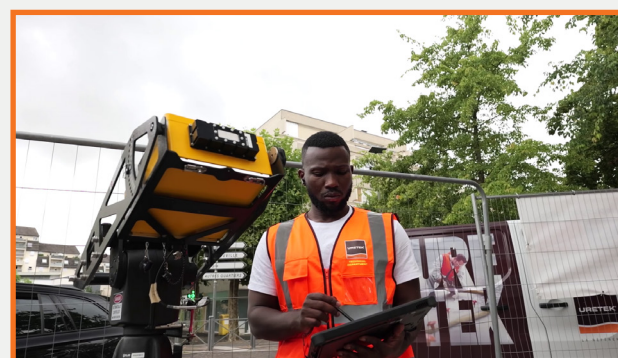
Phases de surveillance par l'ingénieur Uretek
