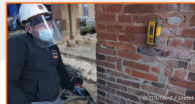
Injection en cours sous monitoring laser
