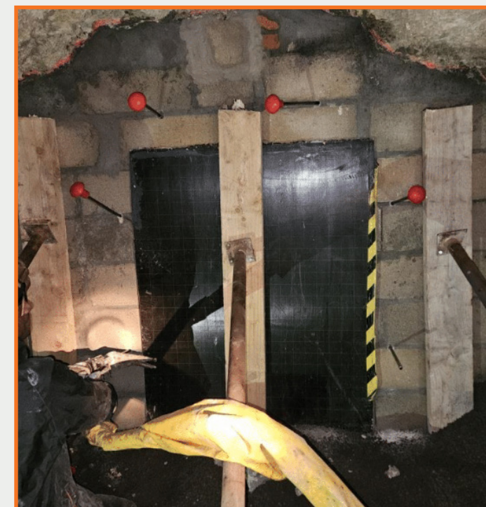
Injection de résine expansive effectuée à travers un mur de confinement préalablement mis en place
