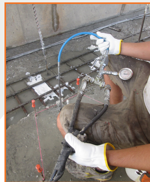
Réalisation des injections
