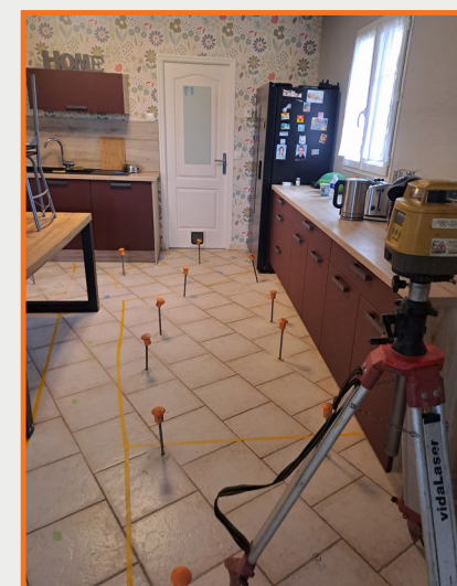
Mise en place des canules d'injection pour le relevage du dallage
