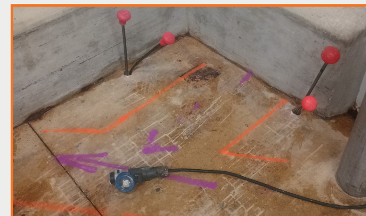
Canules d'injections mises en place
