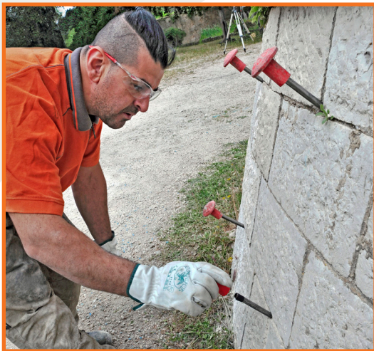
Introduction des tubes d'injection
