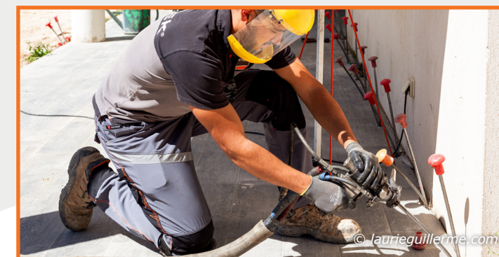
Injection de la résine exclusive Uretex
