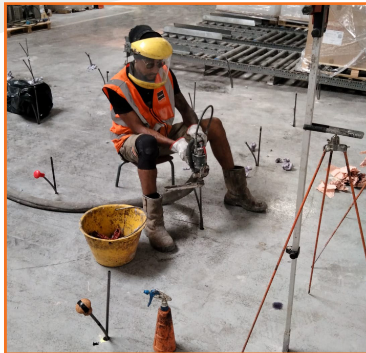
Réalisation des injections de résine
