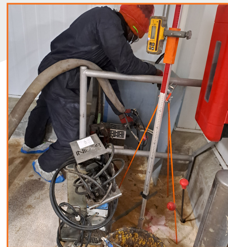
Réalisation des injections de résine
