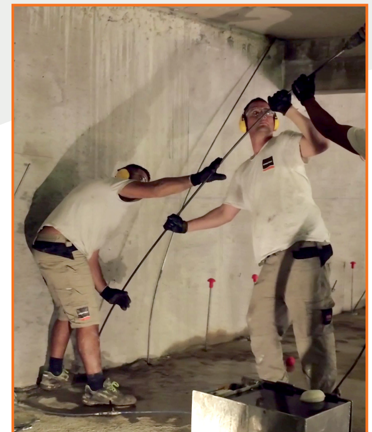
Mise en place des canules d'injection
