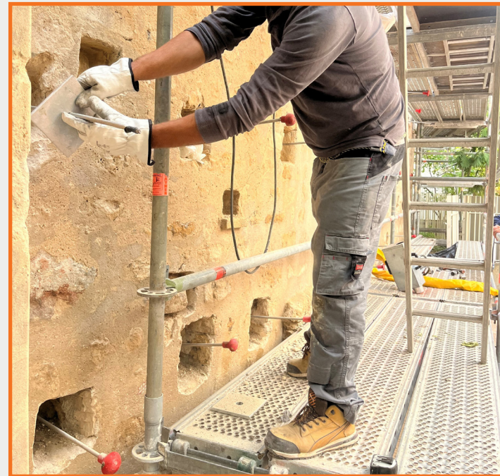
Installation des MicroAnchors
