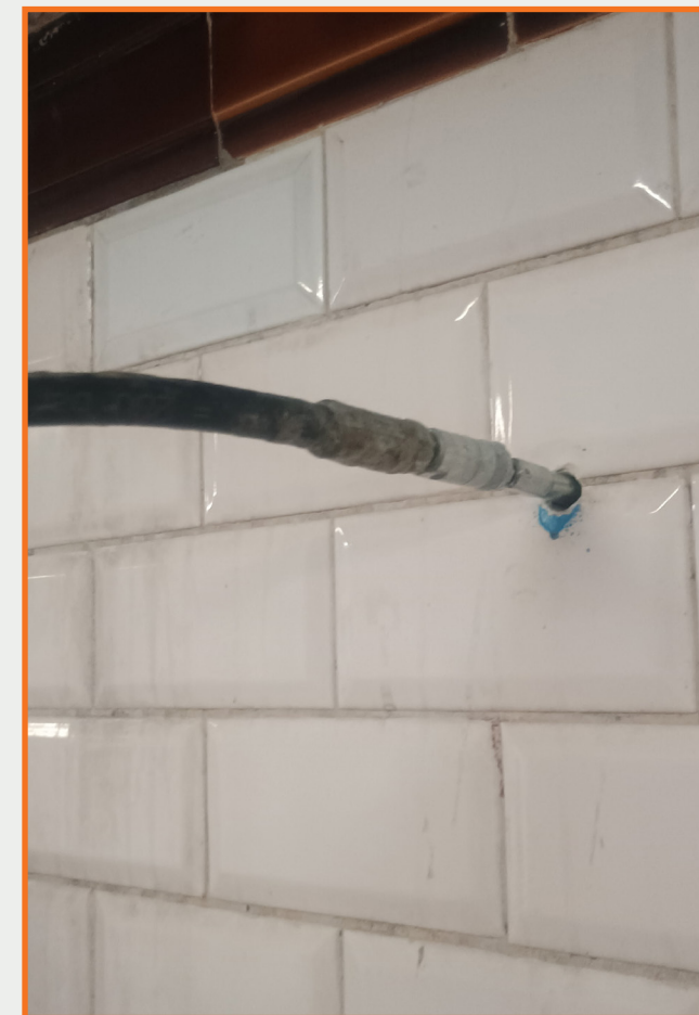
Injection du gel saturant
