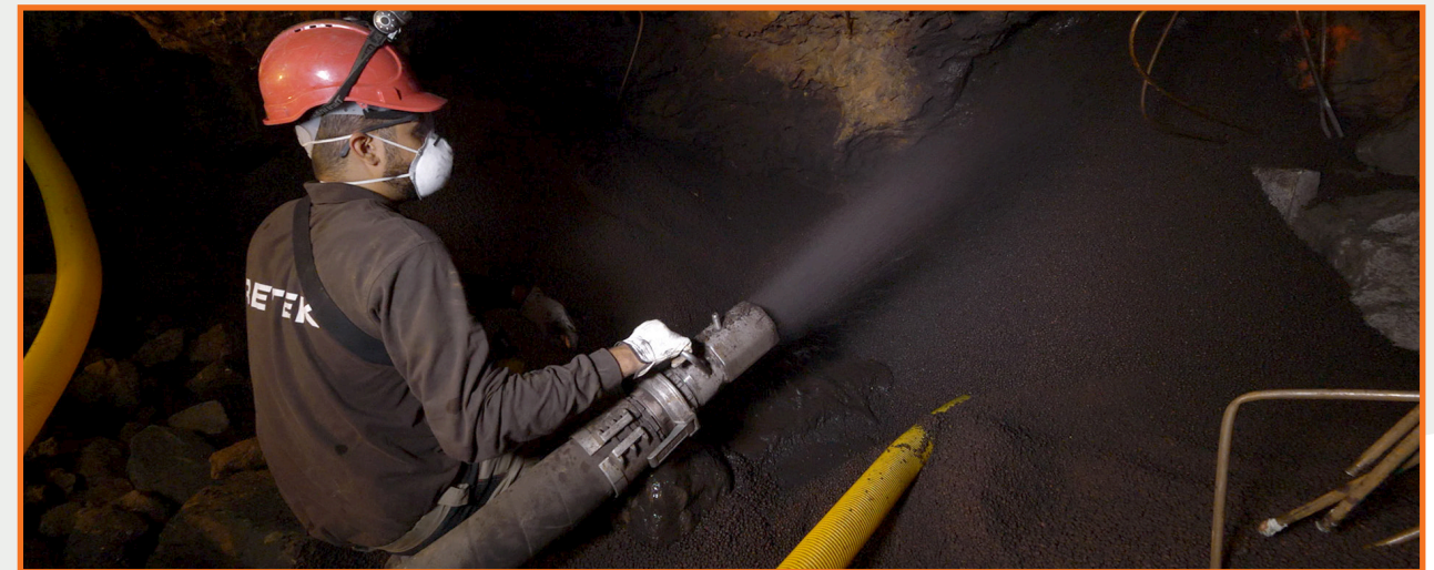
Soufflage des billes d'argile expansée à l'intérieur du volume à combler
