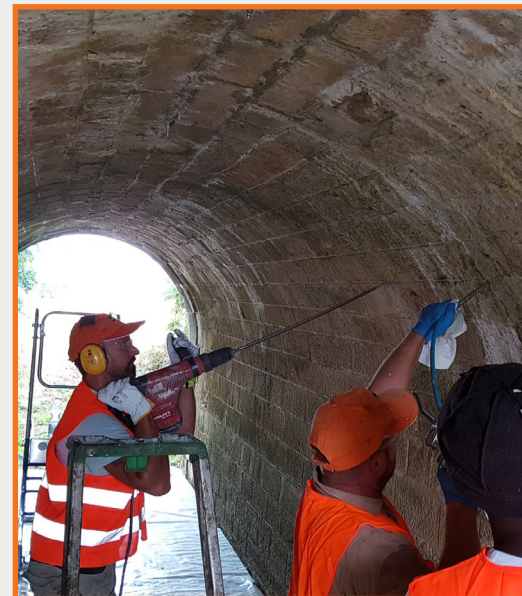
Réalisation des percements
