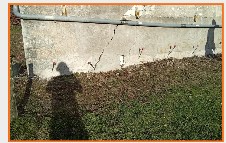
Préparation des injections : installation des canules et niveau laser
