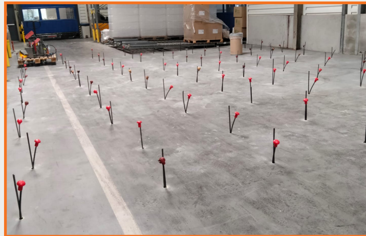
Tubes d'injection disposés selon le maillage prédéfini
