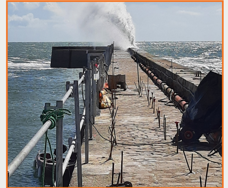
Positionnement des canules d'injection sous les vagues
