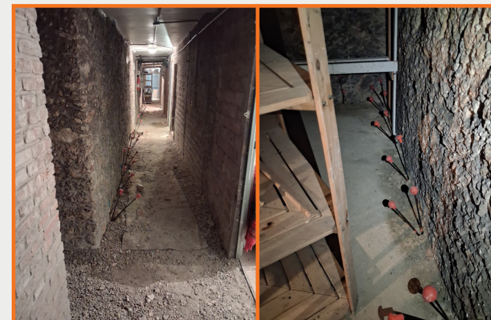
Tubes d'injection en attente dans les caves
