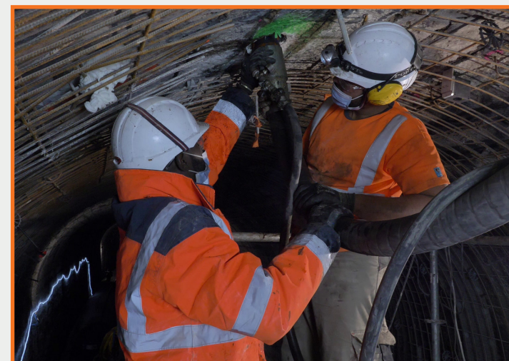
Soufflage des billes d'argile dans la cavité
