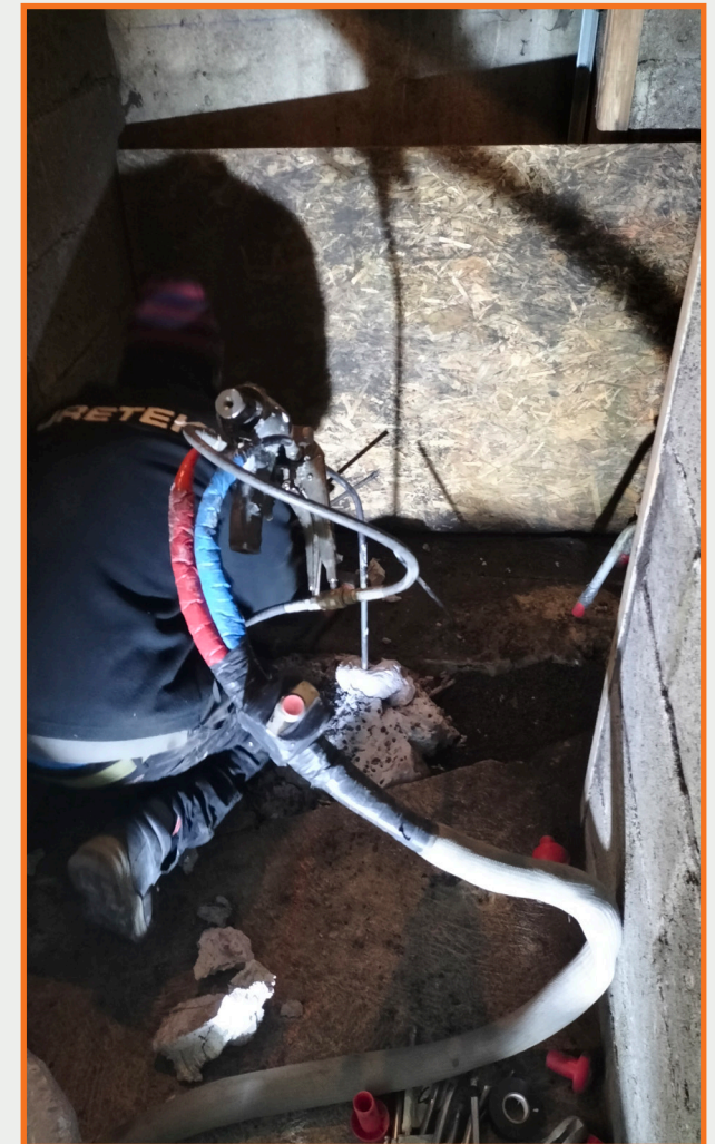
Réalisation des injections de résine au droit de la cavité
