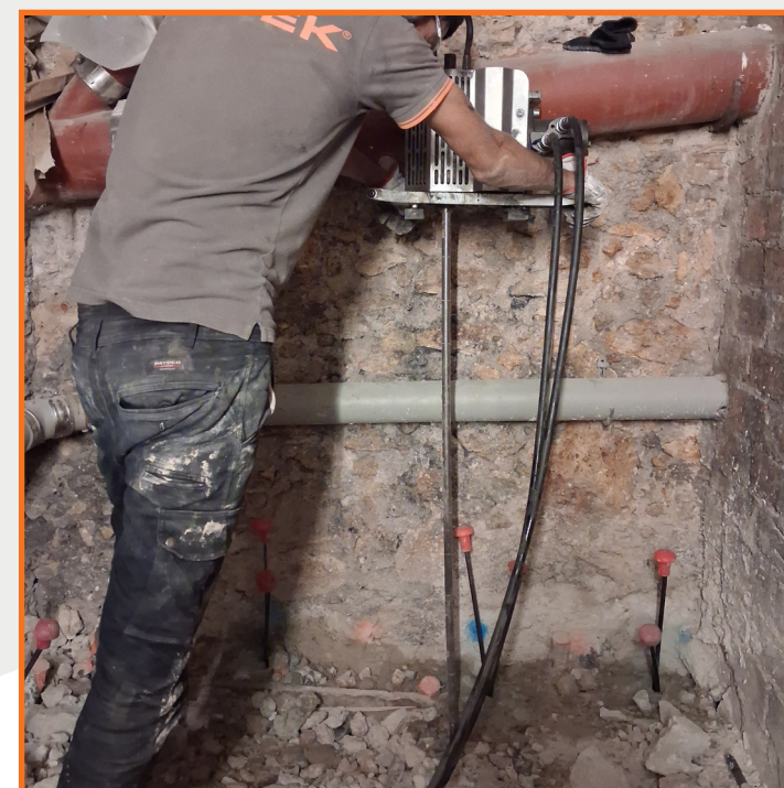
Réalisation d'un test pénétrométrique de contrôle
