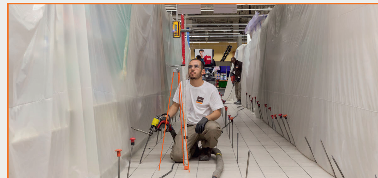
Réalisation des injections sous contrôle laser
