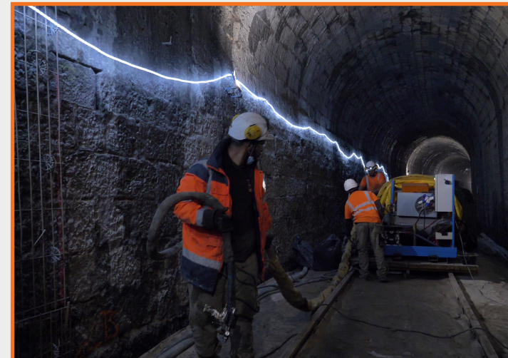
Installation de l'atelier-mobile à l'intérieur du tunnel
