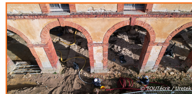
Vue aérienne des injections au niveau des massifs
