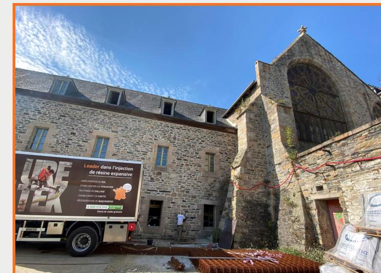
Préparation de la zone d'injection : réalisation des percements
