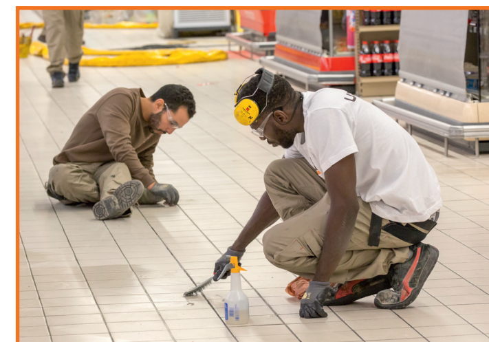
Finitions avec le rebouchage des trous et le nettoyage de la zone traitée
