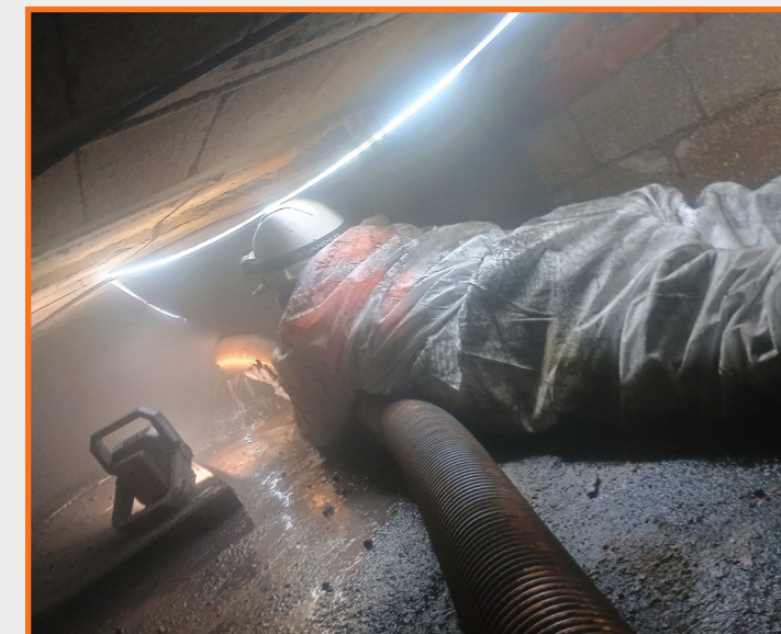
Technicien dirigeant le soufflage des billes d'argile à l'intérieur du vide sanitaire
