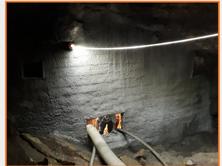
Barrages de maçonnerie et béton projeté installés préalablement par EIFFAGE
