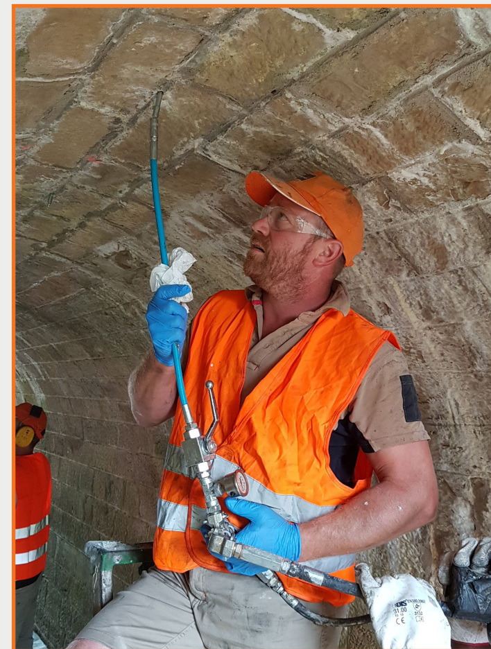
Injection du gel saturant
