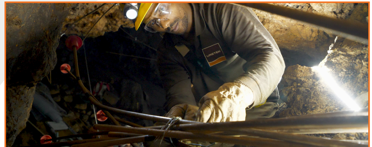
Installation des canules d'injection
