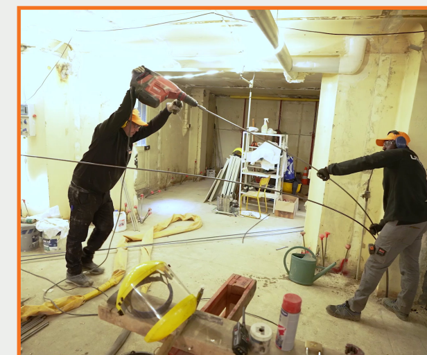
Installation des canules d'injection depuis le sous-sol
