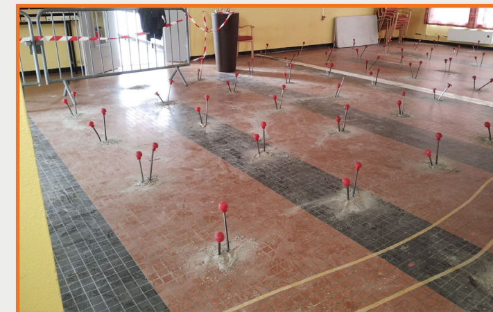
Préparation des canules d'injection
