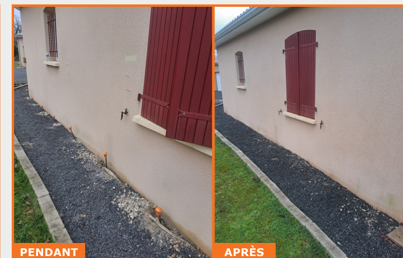
Traitement des fondations avec le procédé Deep Injections (pendant puis après intervention)
