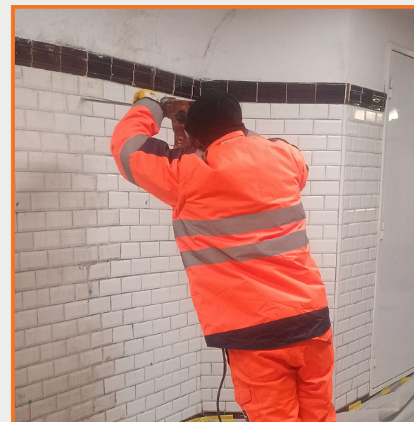
Percement des trous dans la structure enterrée
