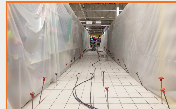
Protection des rayons et mise en place des tubes d'injection
