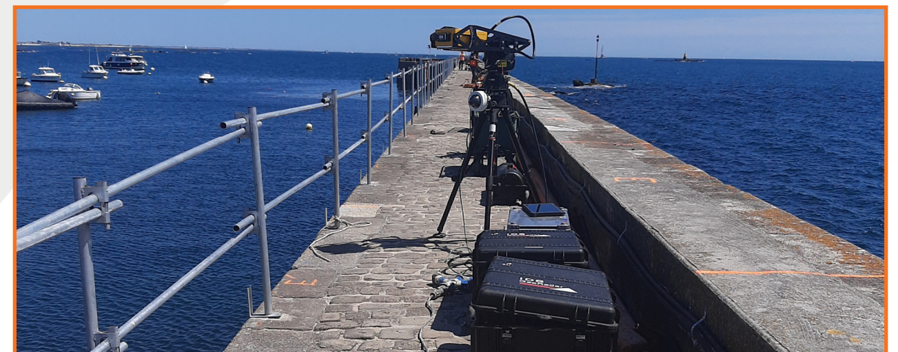
Mise en place de la surveillance au radar 3D
