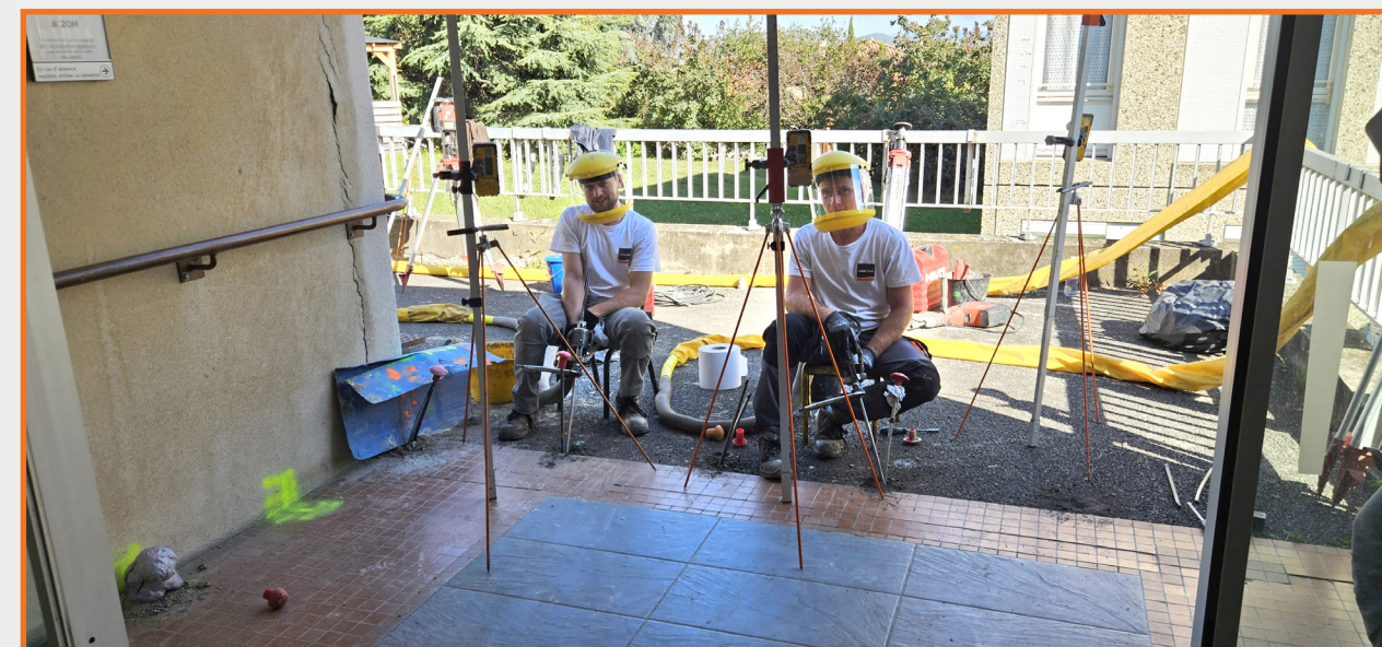
Réalisation des injections de résine
