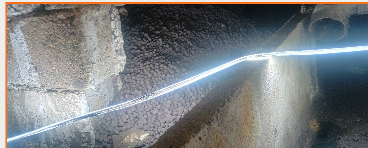
Cavité remplie par les billes d'argile expansée
