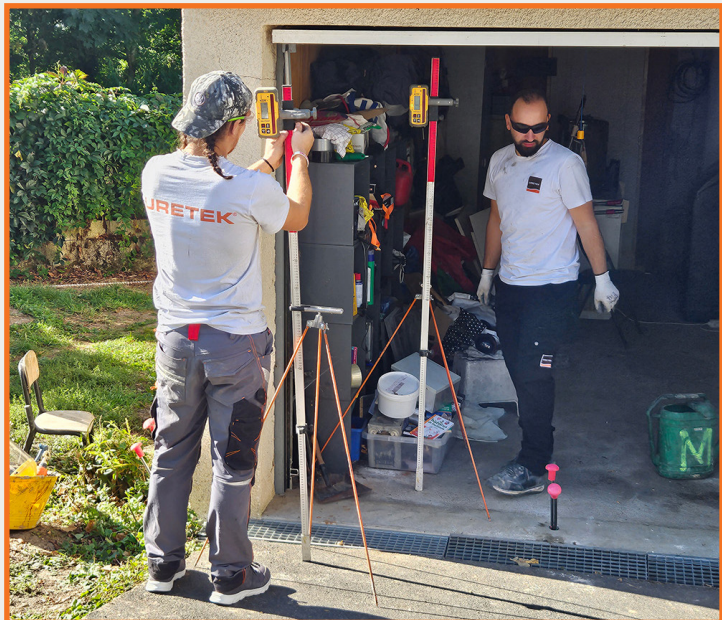
Mise en place du niveau laser
