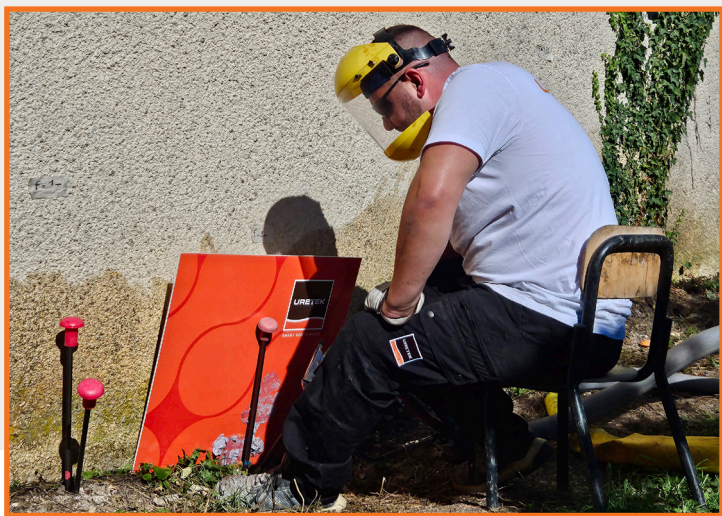
Réalisation des injections par intermittence
