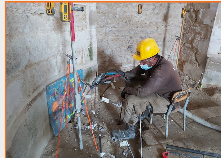
Injections de résine expansive Geoplus Premium
