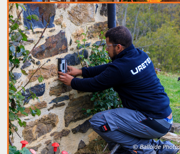
Installation de la surveillance par niveau laser en extérieur et en intérieur
