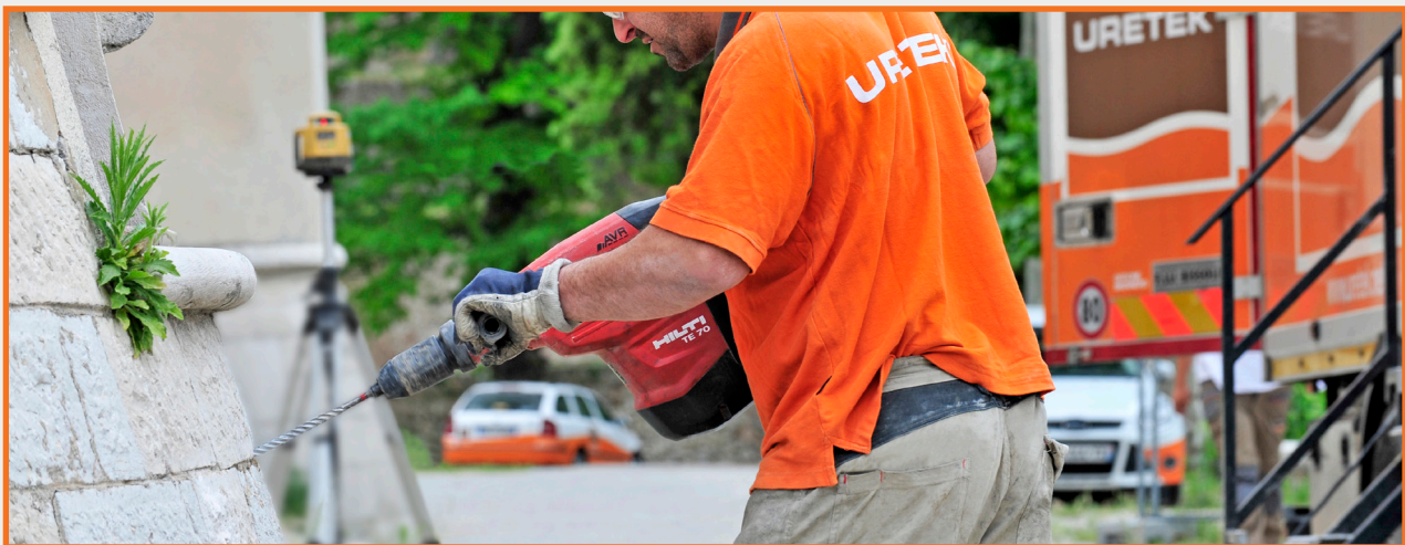
Perforation des trous dans la maçonnerie
