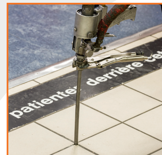
Sensible au détail, Uretek réalise ses injections à travers les joints du carrelage
