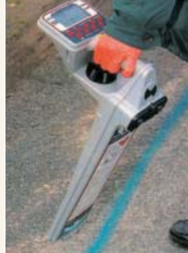
Retraçage d'une canalisation enterrée.
