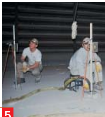
Contrôle permanent des injections au niveau laser.
