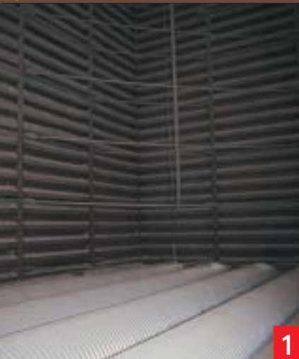
Silo avec son plancher métallique ventilant d'origine.
