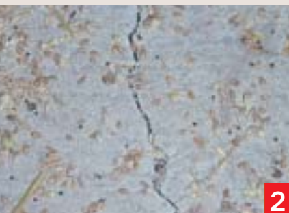
Les mouvements subis par la dalle béton ont généré des fissures.
