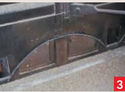
Le plancher métallique est démonté pour permettre de conforter la dalle béton.
