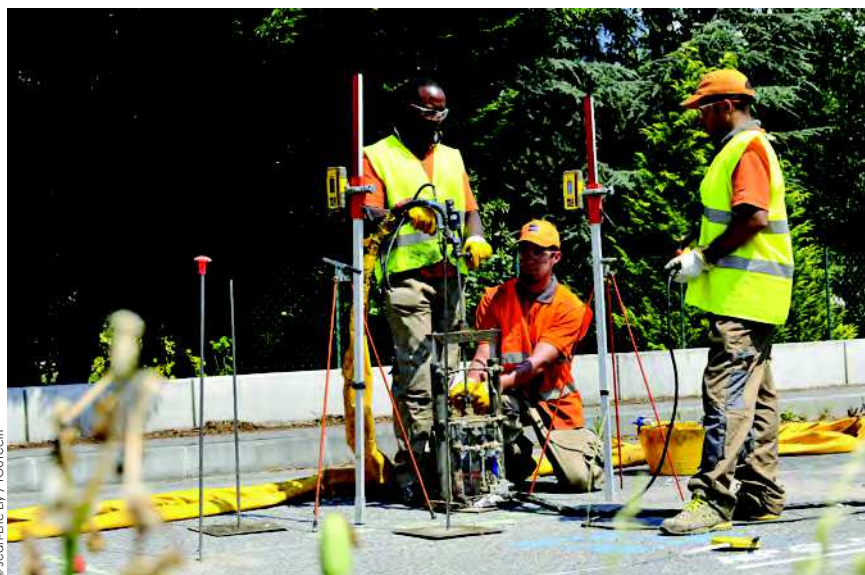
Réalisation des injections avec retrait des tubes d'injection sur le chantier de la RD 990 à Gilly-sur-Isère.
