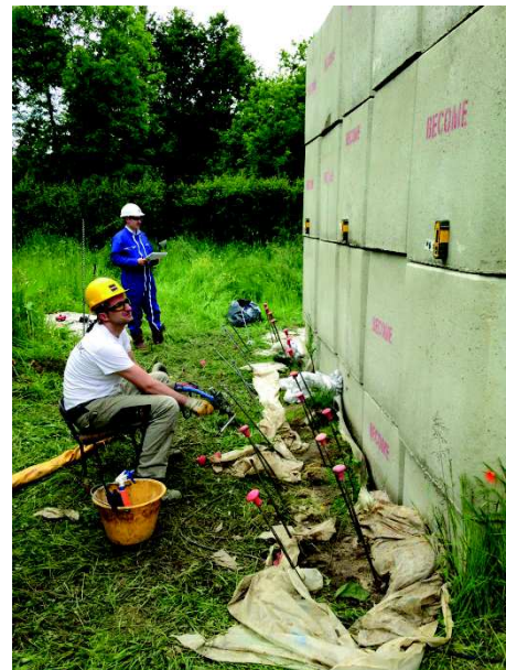
Photo 3[b]. Injection du second niveau sous contrôle laser permanent.
