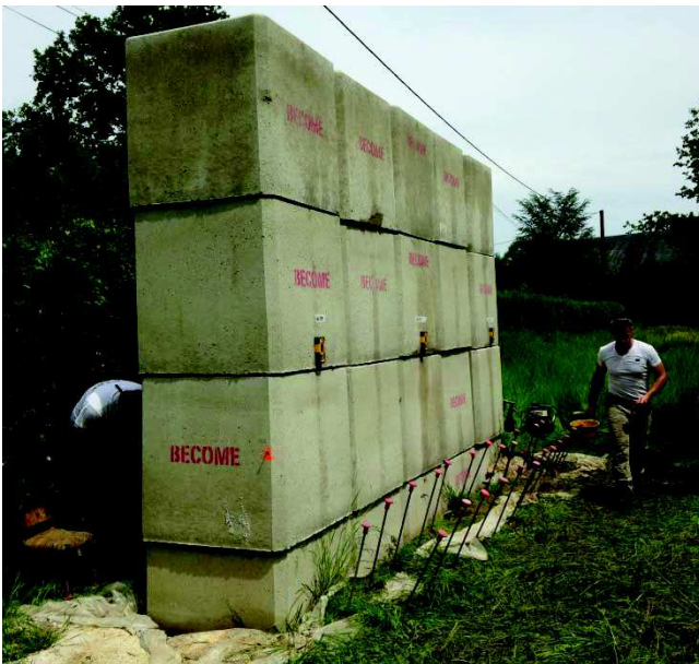
Photo 3[a]. Préparation de l'injection du premier niveau.
